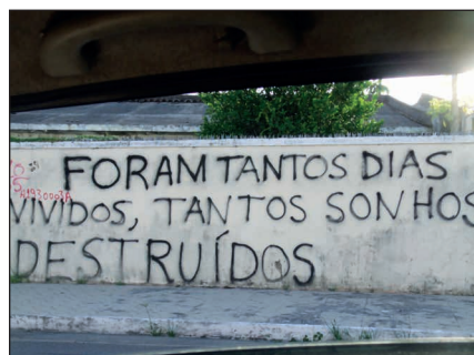
Figura 4 – Muro pichado no bairro Pinheiro
