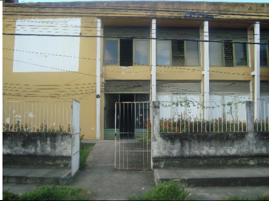
Foto - Vista frontal antigo prédio do MHN, Maceió (AL), 22 de maio de 2018.
