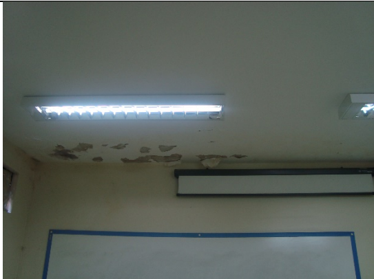
Foto – Térreo, sala de capacitação do laboratório de DNA forense com infiltrações no teto, Maceió (AL), 22 de maio de 2018.
