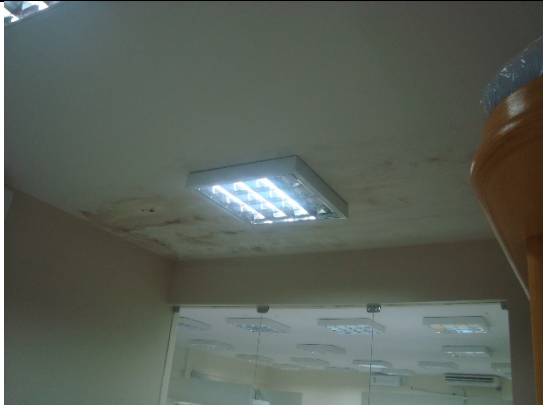
Foto – Térreo, sala de capacitação do laboratório de DNA forense com infiltrações no teto, Maceió (AL), 22 de maio de 2018.
