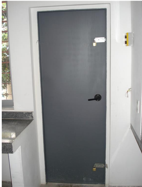
Foto – Saída de emergência do Laboratório Didático nº 3 do IQB/UFAL, em 2015, não sinalizada, de largura menor do que a mínima exigida e localizada vizinha às capelas. Quando da utilização do Laboratório, os cadeados da porta precisam ser retirados. Maceió, 26 de maio de 2015.
