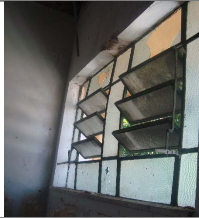
Foto – Parte superior, sala de exposição com viga sobre a janela cedendo, comprimindo-a, Maceió (AL), 22 de maio de 2018.
