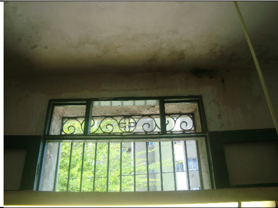
Foto – Paredes com infiltrações do prédio do antigo CCBi, Maceió (AL), 22 de maio de 2018.
