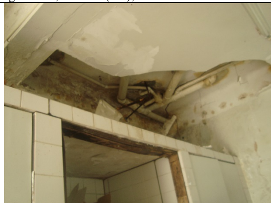
Foto – Gesso do teto quebrado com tubulações expostas, Maceió (AL), 22 de maio de 2018.
