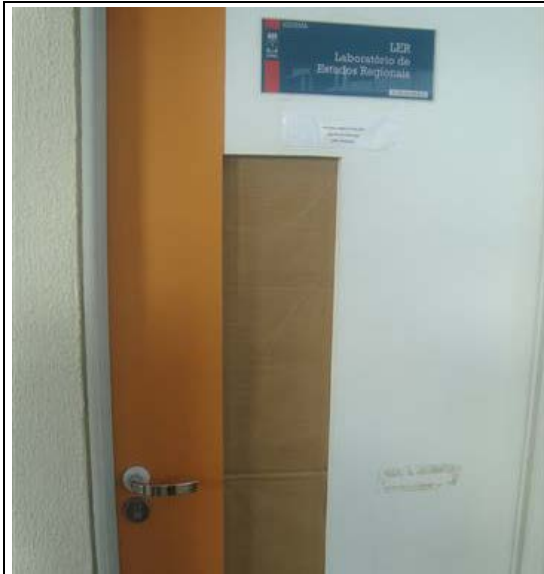
Foto – Porta do Laboratório de Estudos Regionais (LER), onde se observa a bandeira fechada com papelão, em virtude da ausência do vidro. Maceió (AL), 21 de maio de 2018.
