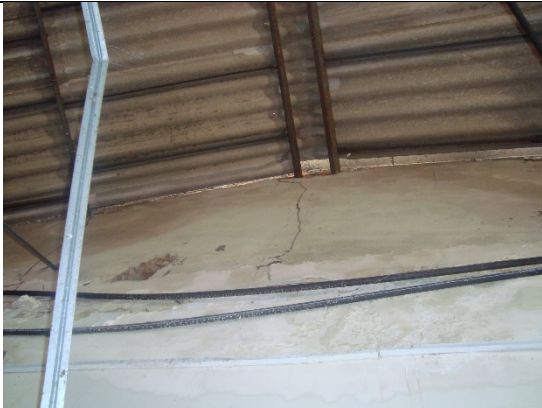
Foto – Parte superior, rachadura na sala de exposição, Maceió (AL), 22 de maio de 2018.
