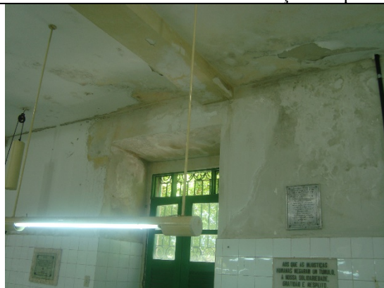
Foto – Paredes com infiltrações do prédio do antigo CCBi, Maceió (AL), 22 de maio de 2018.
