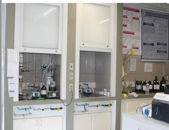
Foto 08 – Exemplo de capelas onde não há comunicação entre cada célula; contendo janelas com sistema de roldanas e contrapesos; e, contendo sistema de gás, vácuo ou ar comprimido, todos acionáveis pela parte externa. Laboratório de Química Farmacêutica da UFSC. Disponível em: <http://gepronas.ufsc.br/infraestrutura-3/laboratorios/laboratorio-de-quimica-farmacutica/>. Acesso em 15 de junho de 2015.
