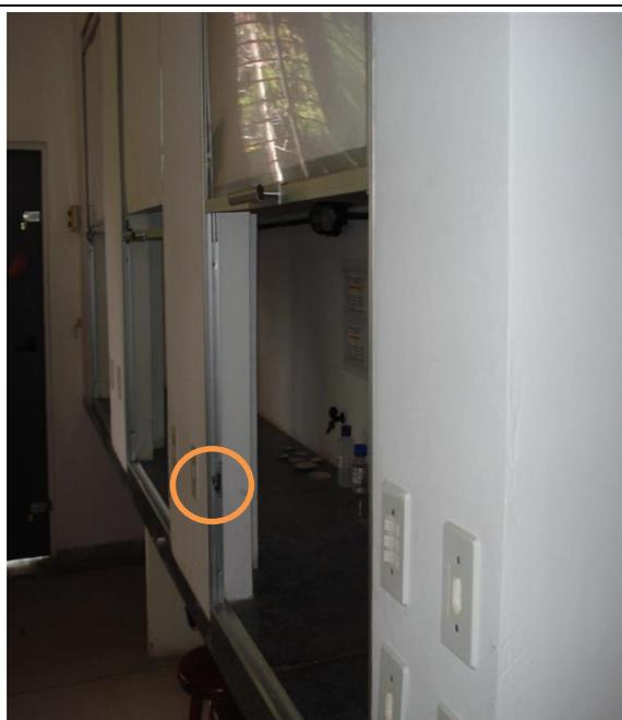
Foto 07 – Capelas do Laboratório Didático nº 3 do IQB/UFAL, onde o espaço entre elas não é isolado, permitindo que gases tóxicos manipulados em uma sejam propagados para a outra; não possuem sistema de gás, vácuo ou ar comprimido; as janelas não possuem sistema de roldanas e contrapesos, sendo fixadas por um suporte, visto no detalhe, e o vidro não é temperado. Maceió, 26 de maio de 2015.
