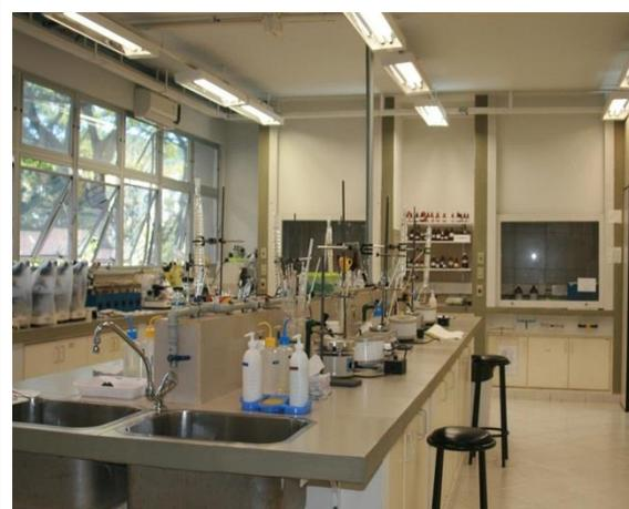
Foto 04 – Exemplo de bancada em ilha contendo tomadas e pias de maior profundidade, para a lavagem de bureta. A bancada ainda conta com uma tubulação de vácuo. Laboratório de Farmacognosia da UFSC. Disponível em: <http://gepronas.ufsc.br/infraestrutura-3-laboratorios/laboratorio-de-farmacognosia/>. Acesso em 16 de junho de 2015.
