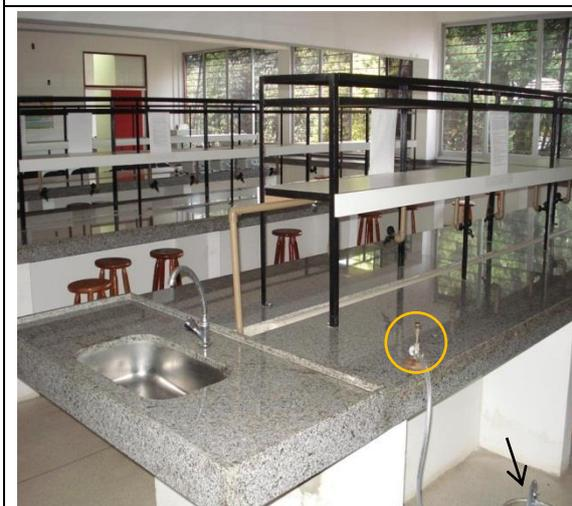
Foto 03 – Bancada em “ilha” do Laboratório Didático nº 3 do IQB/UFAL. Sem instalação elétrica e sem pia funda, para lavagem de bureta. No detalhe, visualiza-se um queimador a gás (bico de Bunsen) ligado a um botijão de gás de cozinha. Maceió, 26 de maio de 2015.
