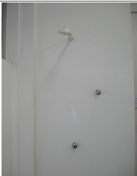
Foto 05 – Chuveiro de emergência do Laboratório Didático nº 1 do IQB/UFAL. Crivo de menos de 30 cm, sem acionamento por alavanca, sem lava-olhos e sem plataforma. Maceió, 26 de maio de 2015.
