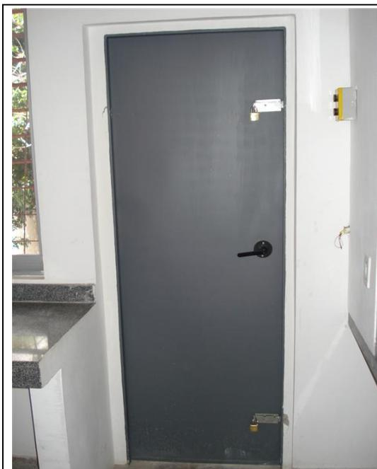
Foto 01 – Saída de emergência do Laboratório Didático nº 3 do IQB/UFAL não sinalizada, de largura menor do que a mínima exigida e localizada vizinha às capelas. Quando da utilização do Laboratório, os cadeados da porta precisam ser retirados. Maceió, 26 de maio de 2015.
