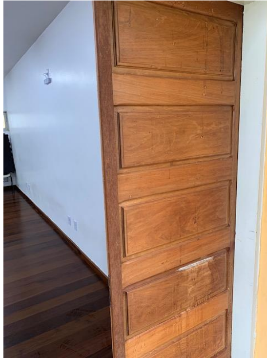
Foto 07: Porta da sala de aula de dança e teatro situado no pavimento térreo da ETA.
