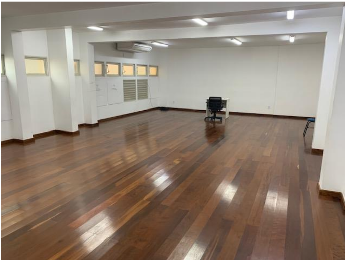
Foto 06: Interior da sala 46 da ETA.
