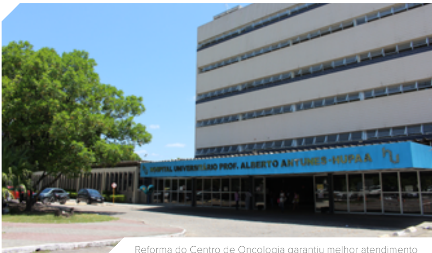
Reforma do Centro de Oncologia garantiu melhor atendimento
