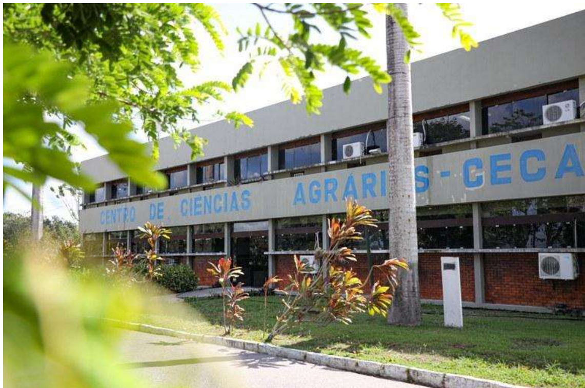
Figura 7– Prédio da Administração Central do CECA-UFAL.
