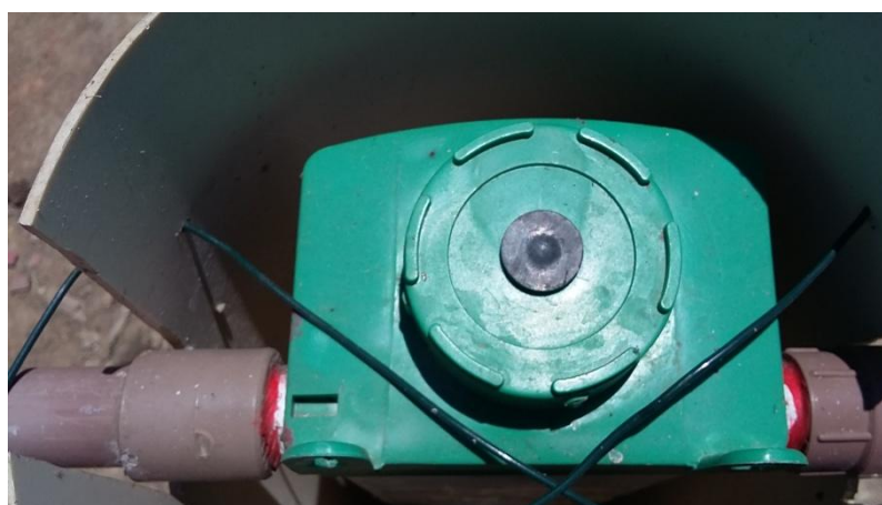
Figura 17: Filtro do Gás Sulfídrico
