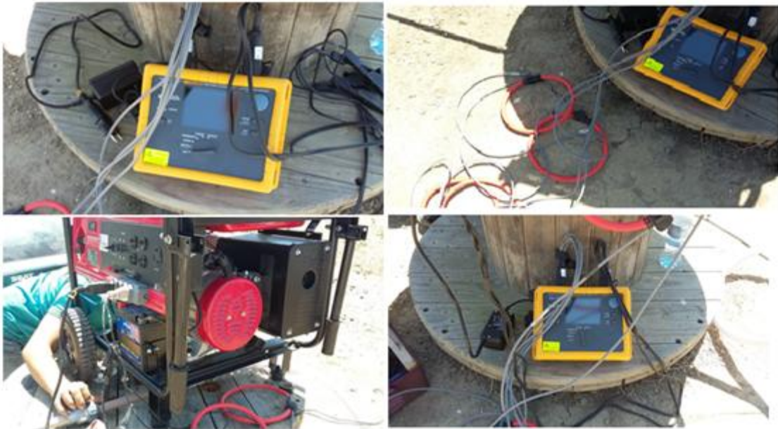
Figura 24: Sequência de Instalação do Equipamento
