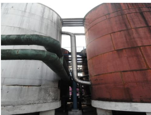
Figura 4.6 – Conexão em forma de S entre dornas.
